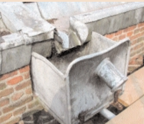
Detail van een loden goot met broekstuk (links-boven), uitloop en een vergaarbak met verklikker (het buisje aan de voorzijde). De vergaarbak is ondersteund met hout op ijzeren beugels om uitzakken te voorkomen
