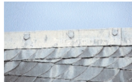
Noklood wordt gebruikt om de nok van een dak waterdicht af te sluiten. De platen lood worden op de zijkant van de nokruiter gespijkerd. De spijker wordt waterdicht afgedekt met een trotseerloodje
