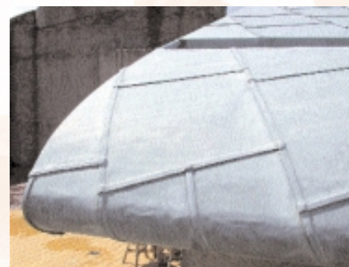
Detail van een loden dak. De platen lood zijn aan elkaar bevestigd met een aanbaak of platte fels. Het lood is om de ronding van het dak geklopt
