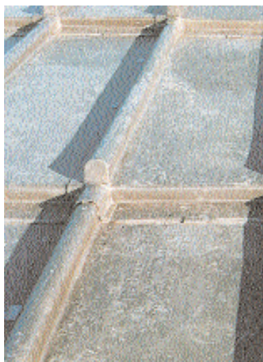
De platen van een loden dakbedekking kunnen verticaal ook aan elkaar worden bevestigd met een roef. Anders dan bij zink, waar de roef hoekig is, is de roef bij lood rond om scheurvorming te voorkomen (Bron: Lood in de bouw, SIBL 1983)
