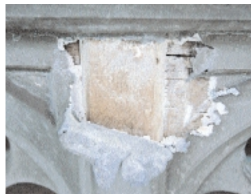
Lood wordt aan de achterzijde aangetast door condens en zuren uit het achterliggende eikenhout. Het lood wordt dan omgezet in loodoxide, ook wel loodwit genaamd. Doordat de aantasting niet zichtbaar is, is het lood vaak bijna geheel omgezet en is de schade groot
