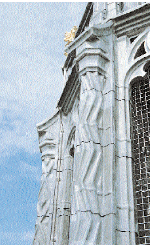
Door de lage stijfheid van het metaal laat lood zich uitstekend in bepaalde vormen kloppen, zoals hier bij de torenspits van de Grote of St.-Bavo te Haarlem
