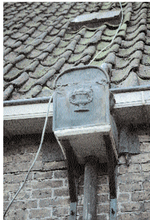
Historische vergaarbak met ornament aan de voorzijde. Behoud staat voorop, de scheur boven het ornament is dan ook geen reden om deze bak te vernieuwen. Reparatie is mogelijk en heeft de voorkeur
