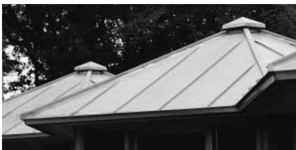
Fig. 21 Felsdak van rechte banen
