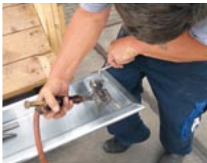
Afbeelding 4.5: solderen van een kop-schot in een bakgoot
