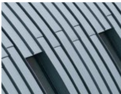
Detail 82: kozijnaansluiting boven
