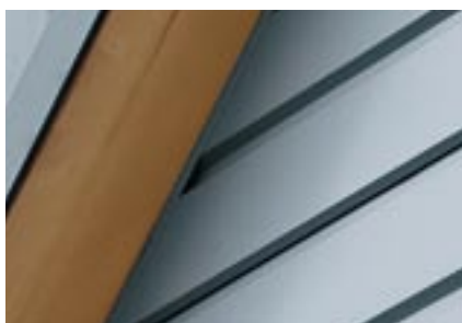
Afbeelding 8.33: Insteekprofiel bij horizontale bekleding onder dakoverstek
