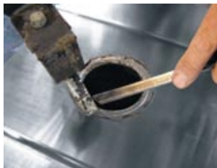
Afbeelding 4.6: solderen tapeind in de bodem van een bakgoot
