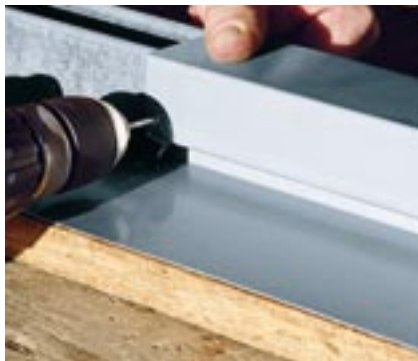
Afbeelding 7.22: voorbereiden van de klik-roefkap en klik-klang
