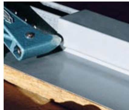
Afbeelding 7.23: vastzetten van de kap met een popnagel
