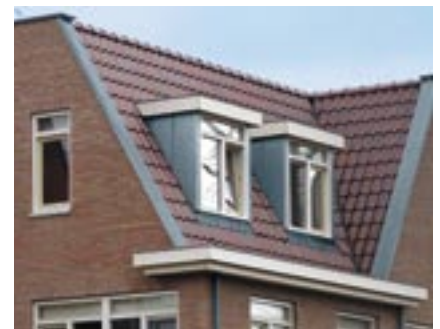
Afbeelding 5.4: dakkapel bekleed met verticale felsbanen
