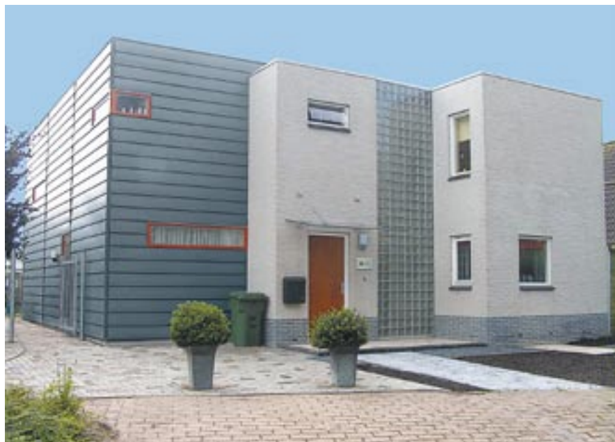
Afbeelding 8.19: woonhuis uitgevoerd met rabatpanelen
