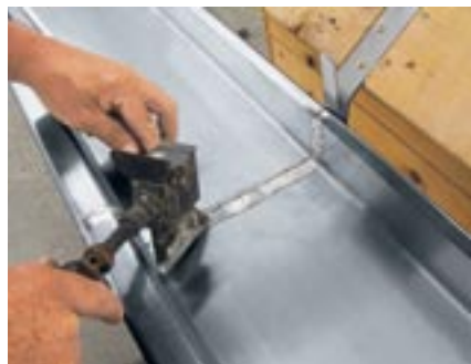
Afbeelding 4.4: solderen bakgoot
