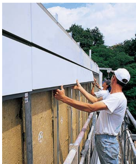
Plaatsing van de horizontale panelen
